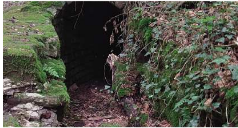
Bei solchen Funden geht Käbisch das Herz auf: Eine Rösche, die das Grubenwasser nach draußen befördert.
